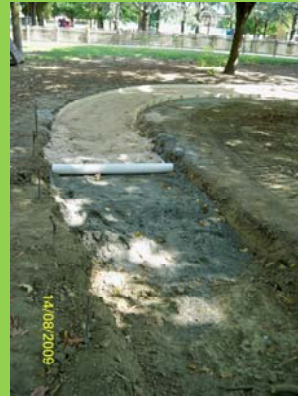
...la posa dei materiali...
