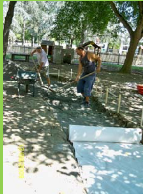
...gli scavi del terreno...
